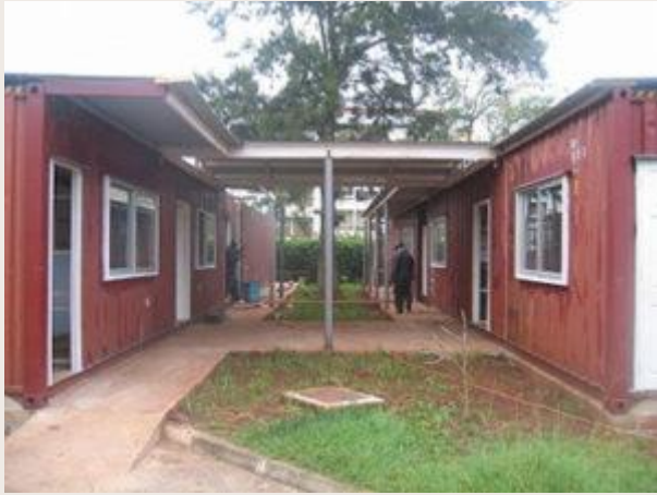
コンテナを用いたケニア拠点事務所の建築風景(2006年)
